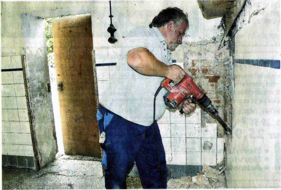
Der alte Putz muss weg: Klaus Hammerbacher aus Horbach, einer der ehrenamtlichen Helfer. Foto: Jakob
